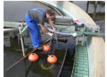
Die Installation gestaltet sich einfach: Weil lediglich eine Haltekette erforderlich ist, können Oberflächensauger schnell in jedem Becken, aber auch in Naturgewässern eingesetzt werden. (Foto: Tsurumi)
