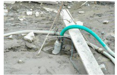
Typischer Einsatz einer Schmutzwasserpumpe im Pumpensumpf einer Baustelle (Foto: Tsurumi)
