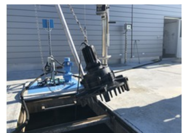
Nach knapp einem Jahr: Tsurumis TRN wird zum ersten Check aus dem Becken geholt (Foto: Tsurumi)
