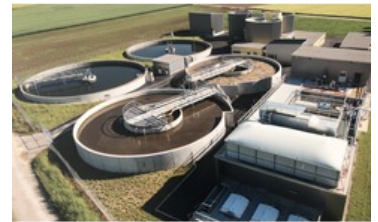
Die Kläranlage "ARA Hallau" des Abwasserverbands Klettgau wurde 1976 in Betrieb genommen und ab 2012 komplett modernisiert (Foto: ARA Hallau)
